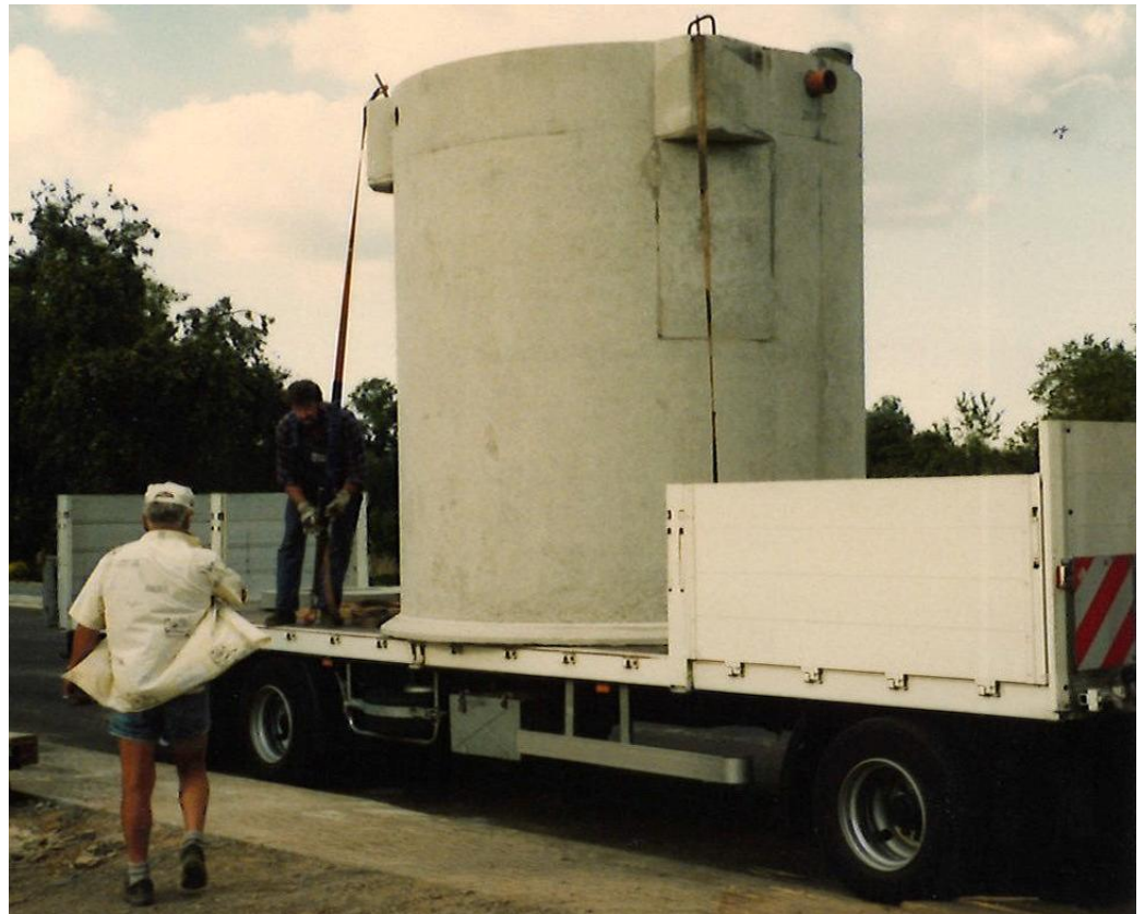
Anlieferung der Zisterne für das Bürogebäude in 1996, Magnolienweg 23, ©bio verlag gmbh
