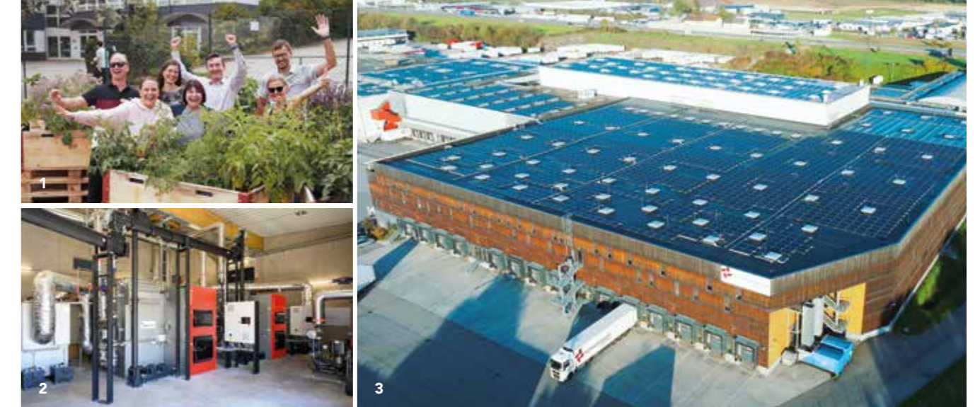
1: Betriebsgarten mit vielfältiger Pflanzenauswahl © Daniel Prieto Taladrid; 2: Neues Biomasse-Heizwerk ersetzt 80 Prozent der bisherigen Gasinfrastruktur © Werner-Kerschbaummayr; 3: Die PV-Anlage in Hörsching produziert Strom für 1.000 Haushalte. © Schachinger Logistik
